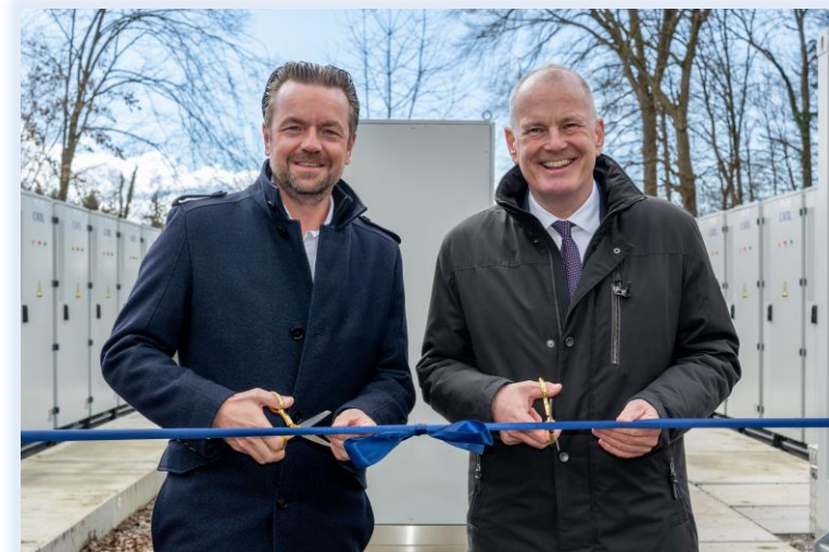
Batteriespeicher in Dättwil
