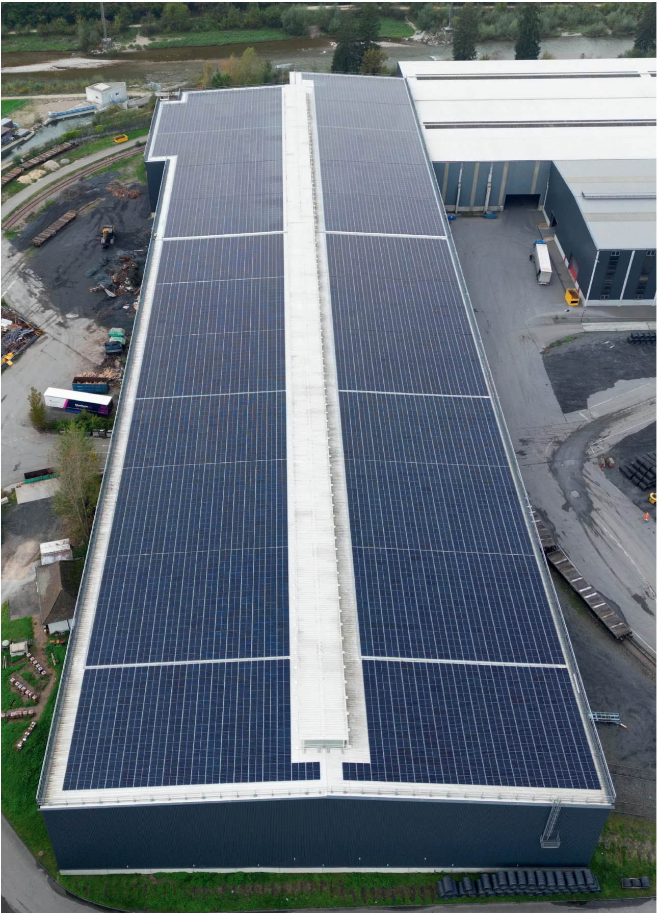
Stahlwerk Gerlafingen mit Photovoltaikanlage der AEW (2,8MWp)
